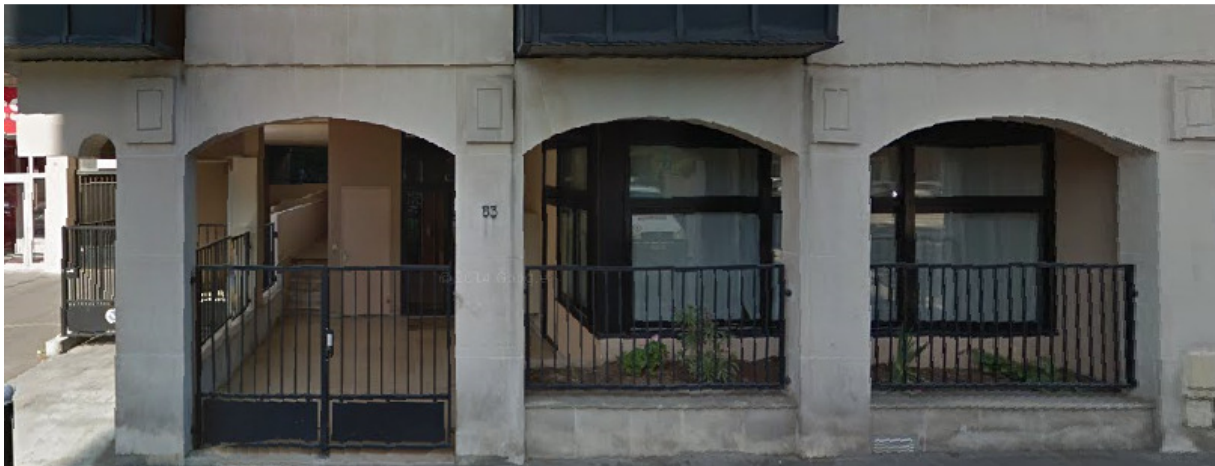
Rue de Lagny, Paris
